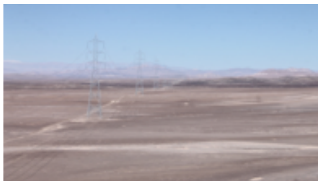
Término construcción Interconexión TEN, agosto 2017.
