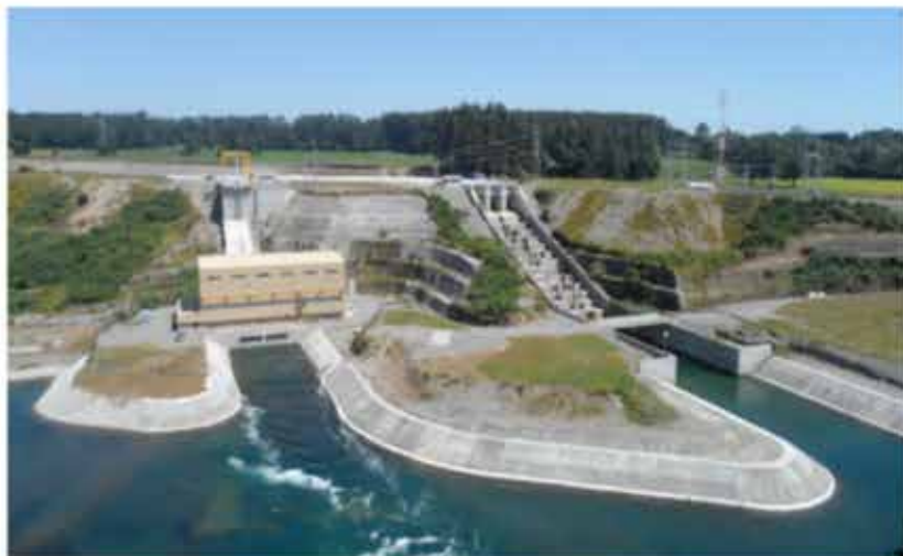
Central Hidroeléctrica Rucatayo, 53 MW
