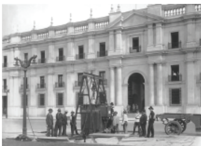
Transformador frente a Palacio de La Moneda, 1930. "Luces de Modernidad", Archivo Fotográfico Chilectra (Enel).
