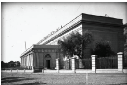
Subestación Eléctrica San Cristóbal, 1923. "Luces de Modernidad", Archivo Fotográfico Chilectra (Enel).
